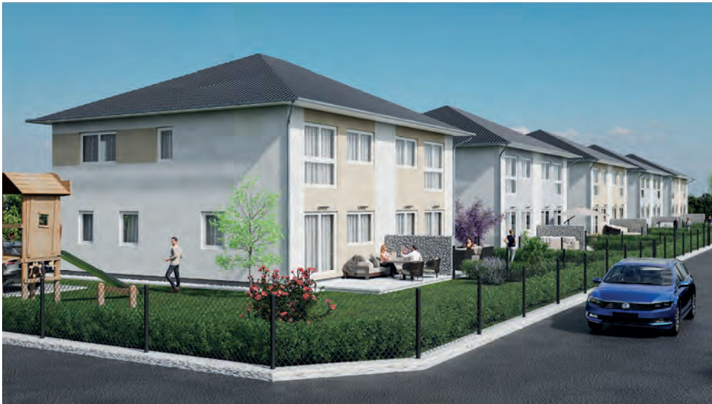
ELK BAU ist Ihr kompetenter und verlässlicher Partner für die Realisierung Ihres Haustraums! Sichern Sie sich Ihr Doppelhaus in Deutsch Wagram zum Mietkauf.
